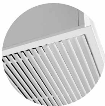
Detal odsłoniętej kratki wlotu
