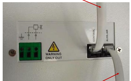
Podłączenie kolejnej kurtyny
