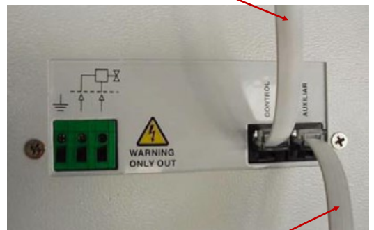
Podłączenie kolejnej kurtyny
