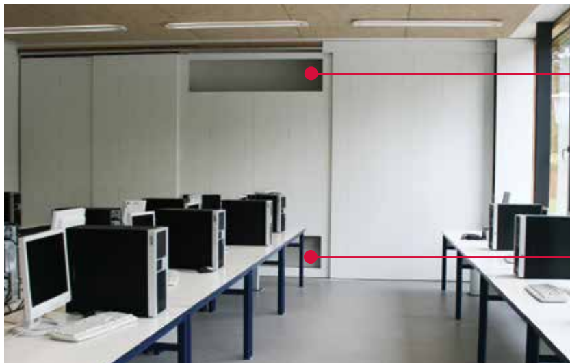
Zabudowanie SupraBOX DELUXE w szafie wnekowej z przesuwającym panelem osłaniającym.
